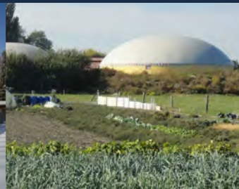
Modules de méthanisation
