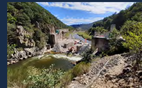
Chantier « Nouveau Poutès »
