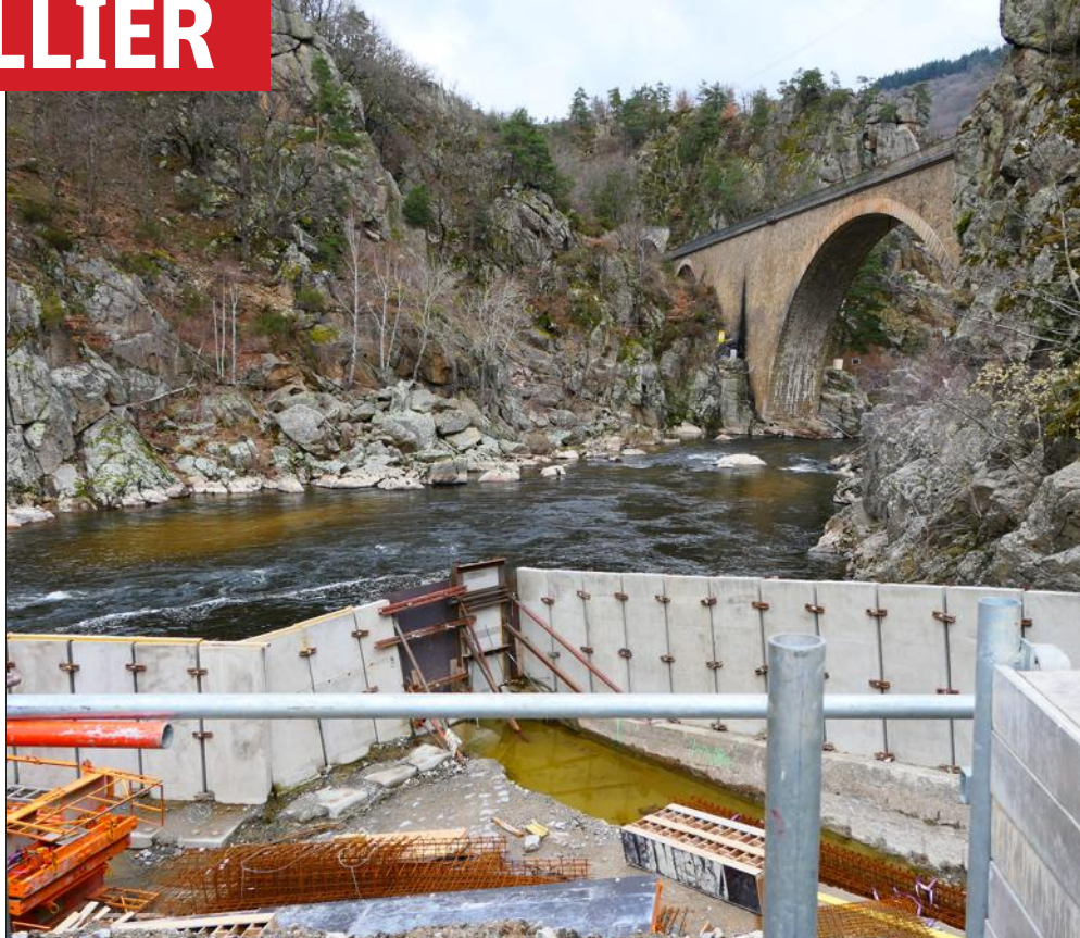
Le nouveau barrage, pensé par EDF, en lien avec des associations de défense de l'environnement, permettra une meilleure circulation du poisson migrateur. Photo Progrès/C. BOUYER PAGE 10
