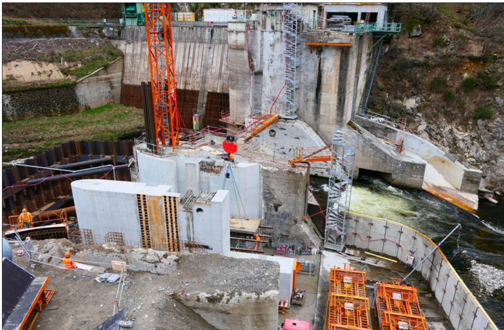
Le chantier vu d'en haut. À droite, on voit l'échancrure aménagée en 2020 pour éviter de noyer le site en cas de crue mais aussi de permettre aux poissons de contourner les travaux. Photo Progrès/Christophe BOUYER
