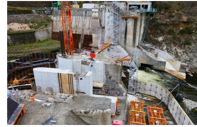
Le chantier vu d'en haut. À droite, on voit l'échancrure aménagée en 2020 pour éviter de noyer le site en cas de crue mais aussi de permettre aux poissons de contourner les travaux. Photo Progrès /Christophe BOUYER
