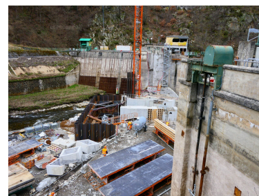
Le chantier a débuté au printemps 2019, il devrait s'achever en début d'année 2022. Photo Le Progrès /Christophe BOUYER
