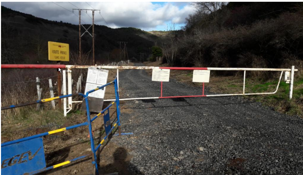
Affichage accès au barrage de Poutès
