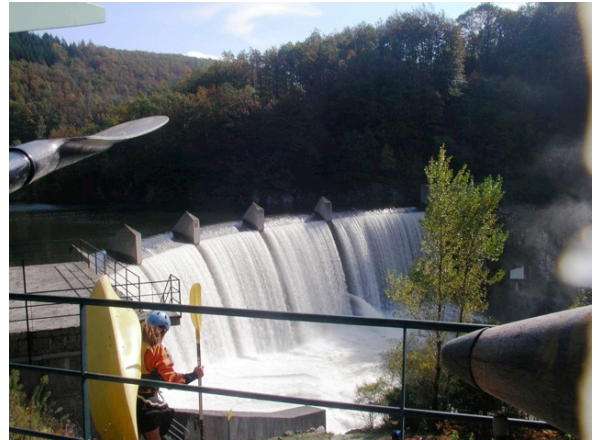
Barrage de Pontviel (départ)
