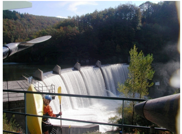
Barrage de Pontviel (départ)
